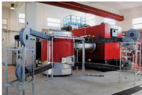
En juillet 2017, sur le site de Torre Nova, en Sicile, Mini Green Power a mis en route une centrale de 2.5 MW thermiques (MWth), avec deux ORC de 200 kW électriques. Cette centrale est alimentée par des déchets verts provenant d'un industriel italien du déchet. Elle produit de l'électricité revendue sur le réseau italien. La chaleur est valorisée localement en chauffage et dans une usine de conditionnement agroalimentaire.
