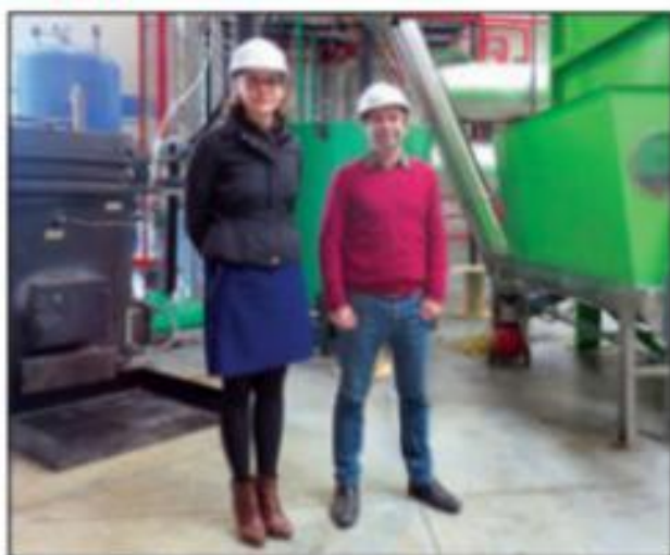
Katarina Reynier et Jean Riondel devant la mini centrale installée à Hyères, dans les locaux de Mini Green Power.
